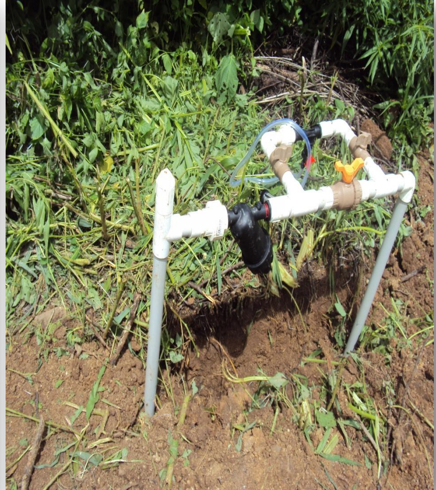
INSTALACION DE SISTEMA DE RIEGO A GOTEO AL INVERNADERO
